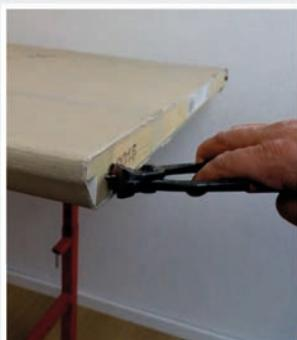
**5** Abstellschutz an der Türunterkante mit der Zange entfernen.
