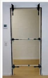
**2** Die zusammengebaute Zarge vorsichtig ins Mauerloch stellen. Zarge mit Türfutter-Richtzwingen in den oberen Ecken fixieren.
