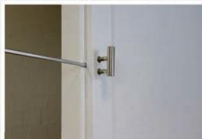
**5** Rahmenteil in die Röhren der Bandaufnahme stecken und mit Inbusschlüssel fixieren. Hinweis: Die Befestigungsschraube liegt verdeckt hinter der Dichtungslippe. Bitte ca. 3 mm Abstand zur Bekleidung einhalten
