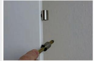
**8** Der Anpressdruck des Türblattes an die Dichtung kann durch Justierung des Fallenschiebers geändert werden. Hierzu die Schraube hinter dem Dichtungsgummi lösen. Nun kann der Fallenschieber justiert werden. Danach die Schraube wieder festziehen.
