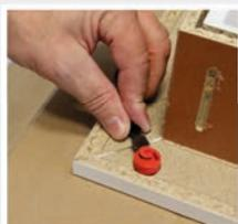
**3** Verbindungsanker in die runden Bohrungen auf der Rückseite der Bekleidungen einstecken und mit Schraubendreher festziehen. Auch hierbei auf Flächenbündigkeit und Passgenauigkeit achten.
