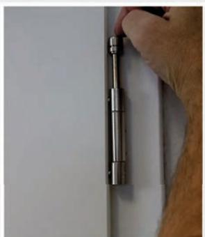
**6** Setzen Sie die Tür vorsichtig auf die Bandteile der Zarge und fixieren Sie das Band mit dem beiliegenden Stift. (Stift von oben einsetzen.) Verschrauben Sie den Stift mit der beiliegenden Schraubkappe.
