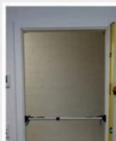
**4** Mithilfe der Wasserwaage Zarge lot- und waagerecht ausrichten. Ggf. durch nachjustieren der Richtzwingen oder Distanzplättchen korrigieren.
